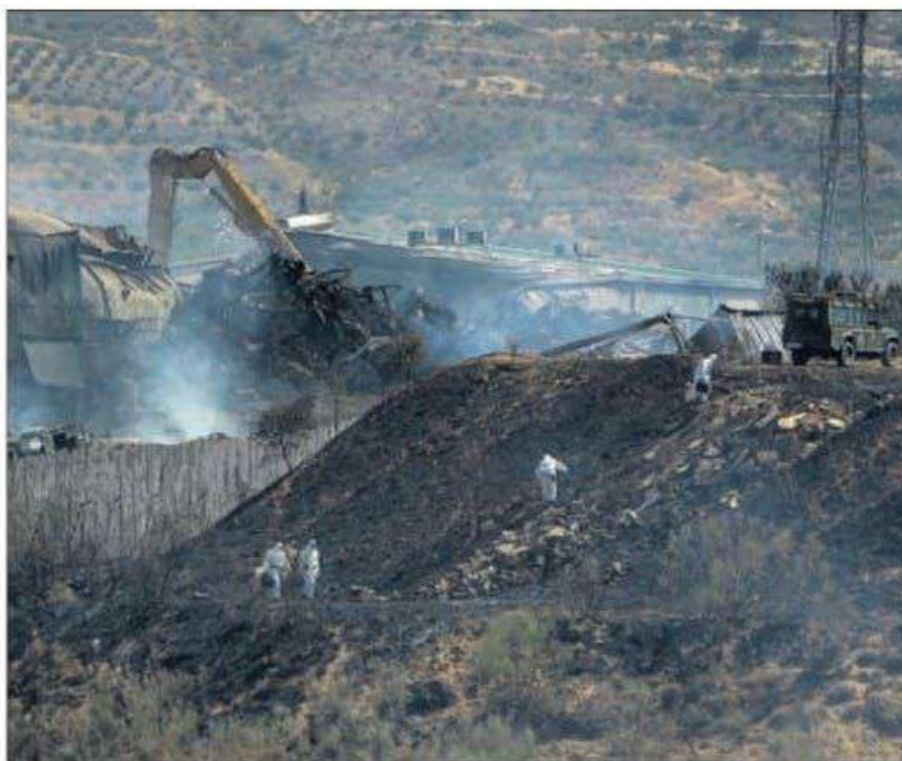
Incendio en la planta de residuos de Chiloeches (Guadalajara), en 2016. / JEFFRE ZAMORA (GETTY)
